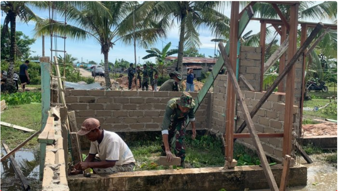
Serma Karno: Tak Ada Kata Lelah, Rehab RTLH Terus Dikebut
